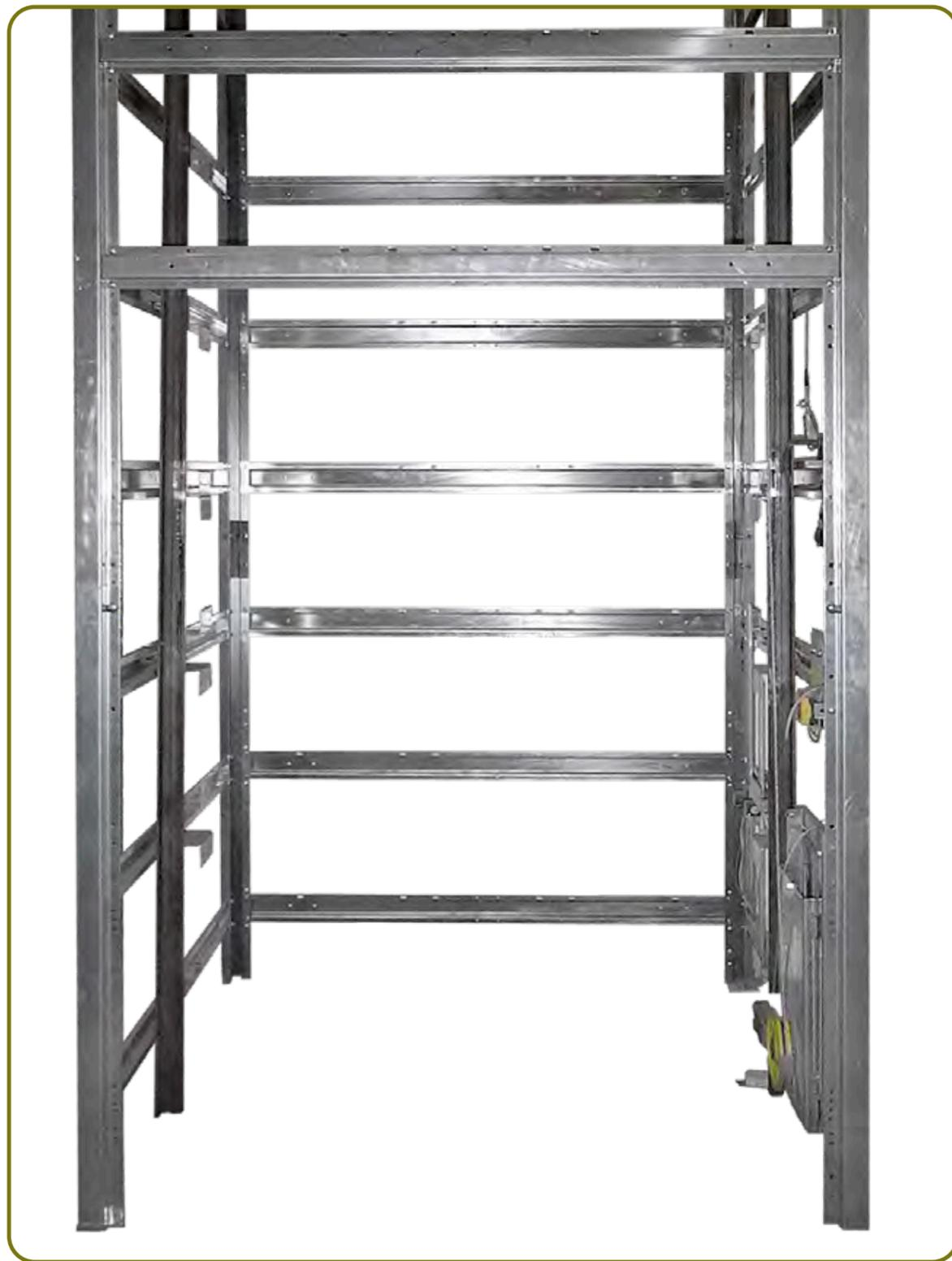
A questo punto è possibile inserire la cabina nell'apposito ponteggio. È necessario muovere la cabina nel ponteggio fino a quando si raggiungono le guide.
