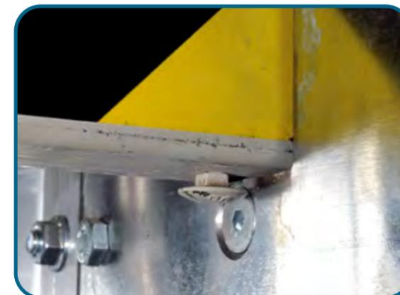
Consigliamo di agganciare il contrappeso in modo allentato ai profili omega. In tal modo il contrappeso può essere spostato ai profili omega durante il montaggio. Inoltre vi è il posto per posizionare le guide accanto ai distanziatori prima di inserire la cabina.
