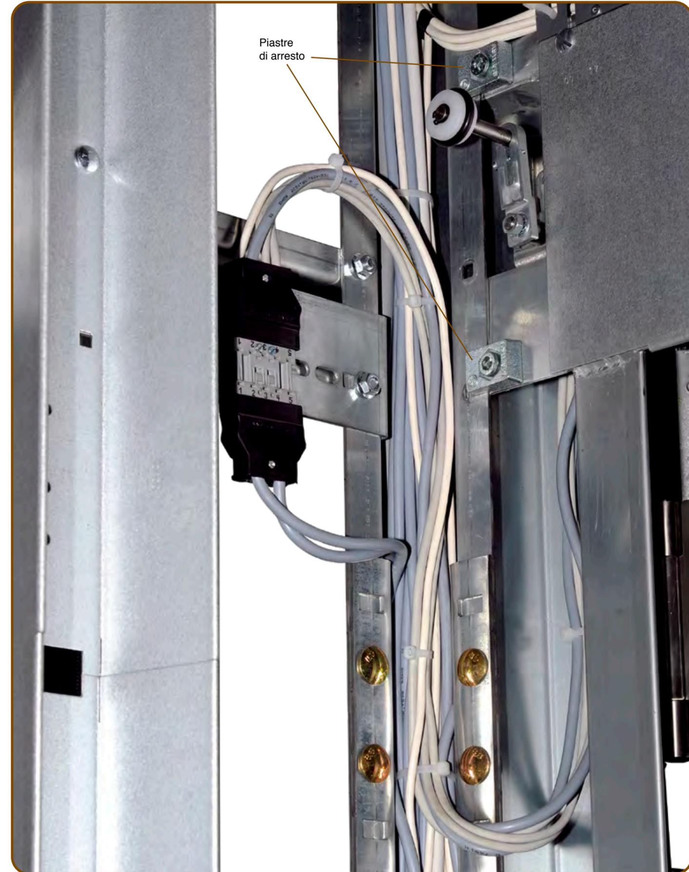
L'interruttore della porta con la serratura è già montato ed è situato nell'architrave superiore. L'architrave è rivestita così che l'interruttore non è visibile dall'interno. I cavi si trovano sulle parti laterali. Quando la porta è aperta si possono vedere sia la serratura che anche il contatto della porta. La frizione del contatto della porta si trova nell'architrave. L'innesto sul battente della porta è regolabile.
