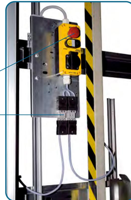
Solo se l'innesto del fermo cabina è inserito nella frizione dell'interruttore di arresto nel vano, l'impianto può essere messo in funzione. Per questa ragione il fermo cabina viene agganciato accanto all'interruttore di arresto nel vano.
