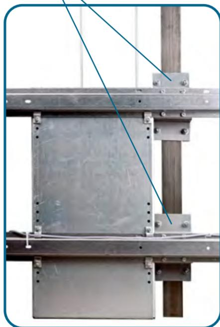
Wenn der Fahrkorb eingesetzt ist und die Führungsschienen auf die Distanzhalter geschraubt sind, wird das Spanngewicht entlang der Hutprofile bis an die Distanzhalter geschoben und festgeklemmt.
