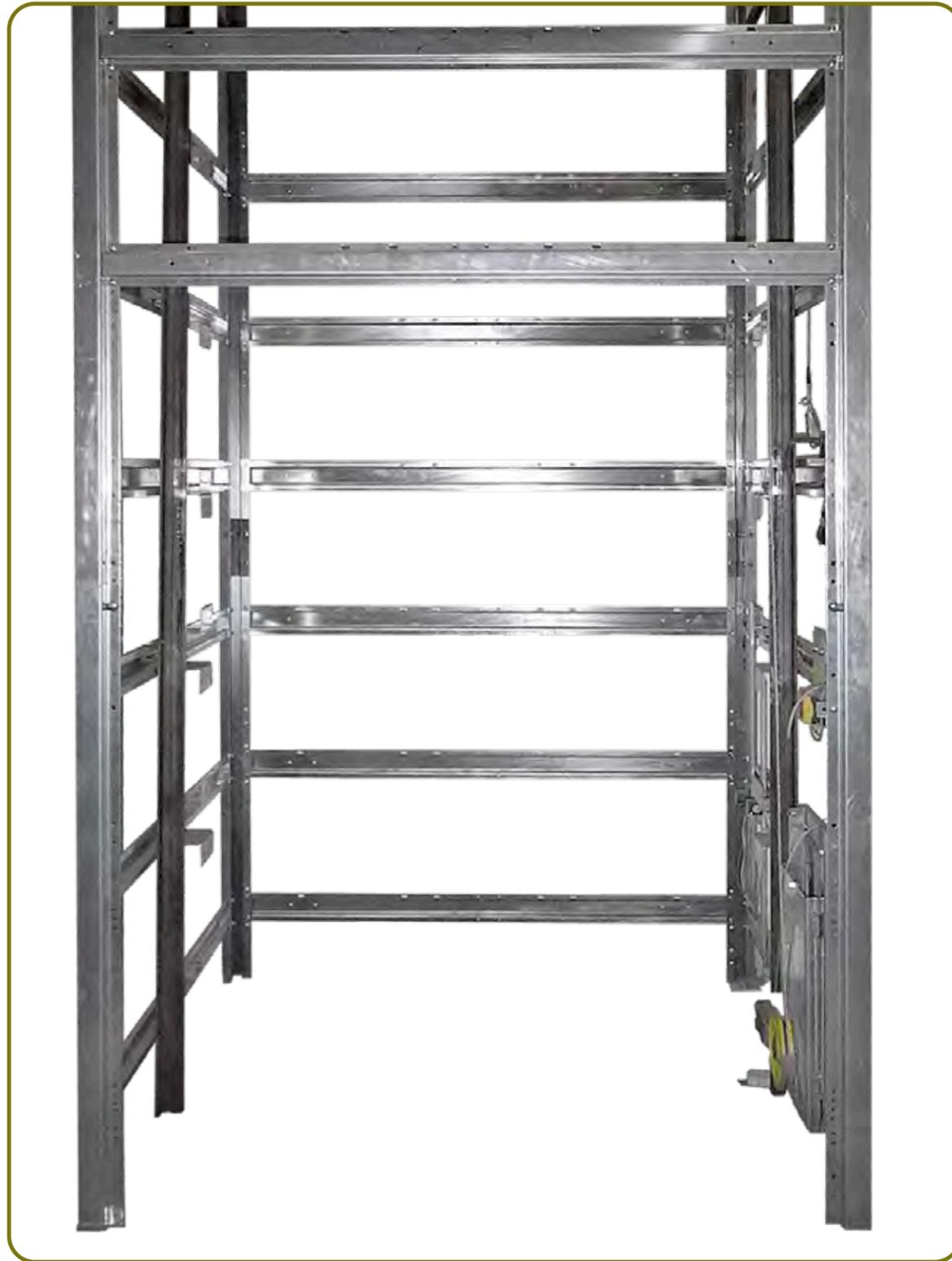
Der Fahrkorb kann jetzt in das vorbereitete Gerüst gestellt werden. Bewegen Sie den Fahrkorb in das Gerüst bis zu den Führungsschienen.
