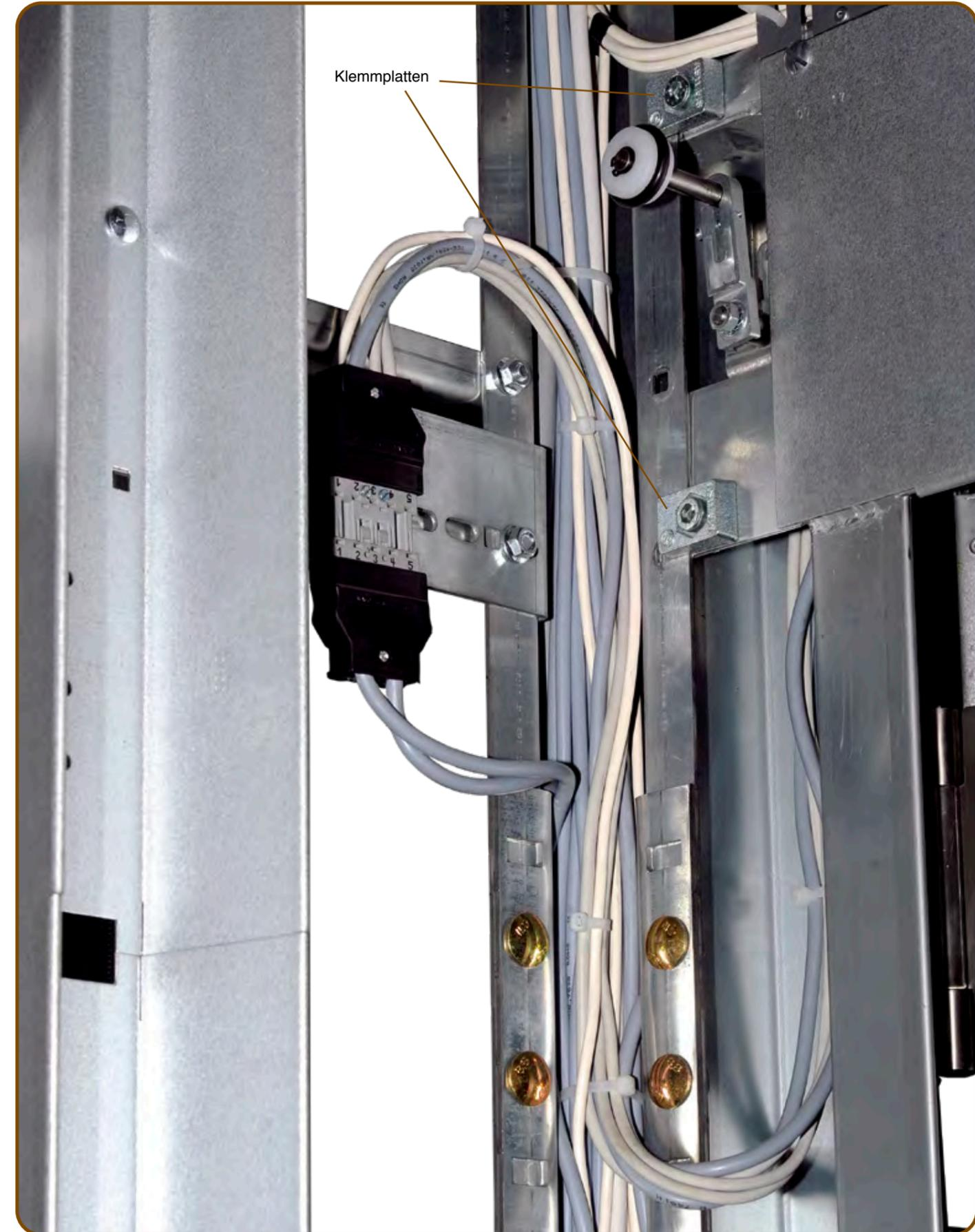
Der Türschalter mit der Verriegelung ist vormontiert und befindet sich in der oberen Türzarge. Die Zarge ist verkleidet, so dass die Schalter an der Tür von innen nicht sichtbar sind. Die Kabel sind seitlich ausgeführt. Bei geöffneter Tür sind die Verriegelung und der Türkontakt sichtbar. Die Kupplung des Türkontaktes befindet sich in der Zarge. Der Stecker an dem Türflügel ist einstellbar.
