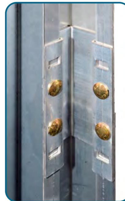
Die Eckstiele werden mit den Verbindungslaschen verschraubt.
