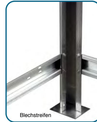
Auf beiden Seiten müssen zwischen der Führungsschiene und dem Hutprofil Distanzhalter montiert werden. Später werden auf der rechten Seite neben den Haltern die Kunststoffrohre befestigt.
