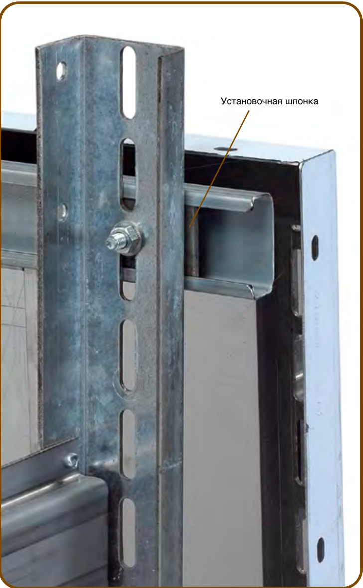
Винтовое соединение со стороны противовеса
