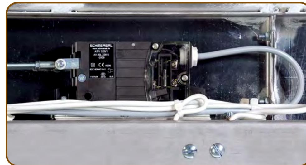
Com a porta aberta é possível ver-se o encravamento e o contacto da porta. O acoplamento do contacto da porta encontra-se no prumo. A ficha do contacto da porta é ajustável. A ponte do contacto da porta tem de ser montada no painel da porta. No prumo superior encontram-se os furos de desencravamento de emergência para as portas. Estão cobertos com cavilhas de enchimento. A chapa de suporte para a ficha e o encravamento da porta é fixada na estrutura.
