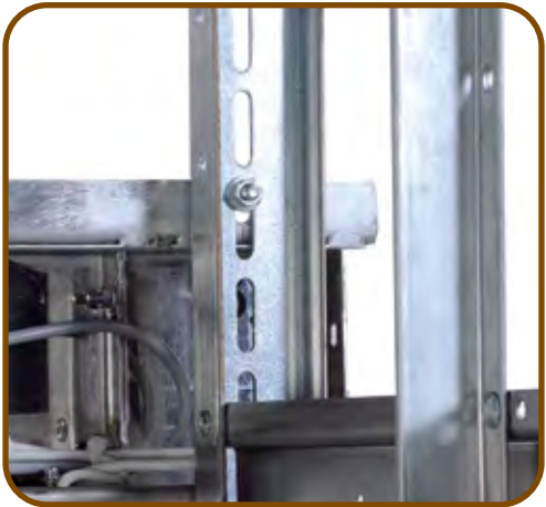
Połączenie śrubowe - strona przeciwwagi
