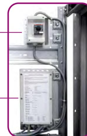
L'interruttore per l'arresto d'emergenza deve essere fissato sul montante angolare in modo da poter essere facilmente raggiungibile. Esso deve essere fissato sulla struttura all'altezza della porta del vano inferiore. Per raggiungere l'interruttore per l'arresto d'emergenza non deve essere necessario entrare in contatto con componenti conduttori di tensione.
