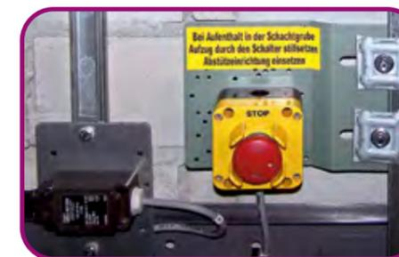
Gli interruttori di fine corsa per la fermata ai piani vengono fissati sulle guide e sono regolabili verticalmente all'interno di esse. Le guide vengono fissate sulle scale della struttura presso i profili a cappello. Gli interruttori di fine corsa per la fermata ai piani devono essere regolati in modo che la cabina si fermi a filo nei piani. Gli interruttori vengono commutati dai dispositivi di azionamento situati presso la cabina e devono essere quindi installati con la massima precisione.
