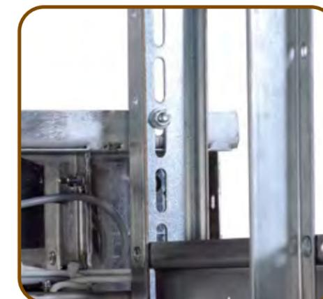
L'interruttore della porta con il dispositivo di bloccaggio porta è premontato e si trova nel telaio superiore della porta.
