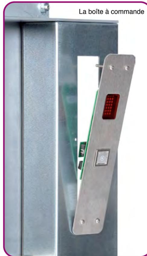
Mettez la boîte à bouton dans le trou du dormant. Fixez avec les quatre vis les brides symétriquement. Montez les boîtes à commande dans les étages correspondantes. Elles sont nommées du bas vers le haut commencent avec le N°1. La dénomination n'est pas la même que la dénomination d'étage sur le plan d'installation. Si il y a deux paliers dans un étage, vous devez brancher l'interrupteur dans l'index A.
