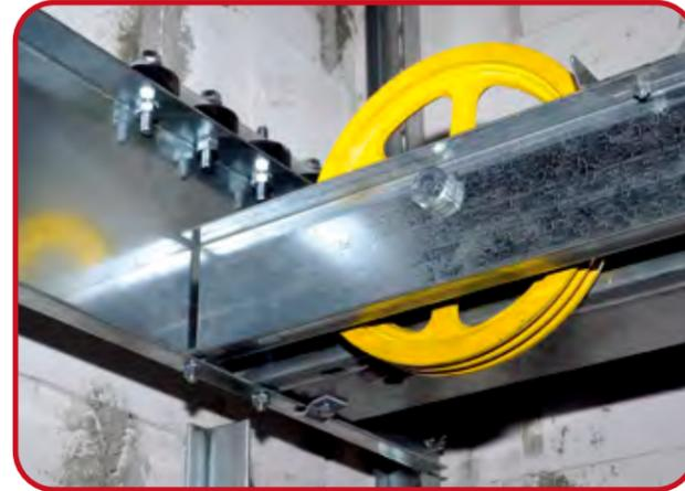
Le câble doit passer du contrepoids par la poulie motrice à la poulie de renvoi et finalement arriver à la benne.
