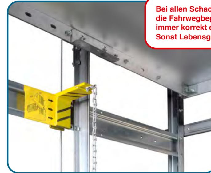
**Bei allen Schachtarbeiten die Fahrwegbegrenzung immer korrekt einsetzen. Sonst Lebensgefahr!**
