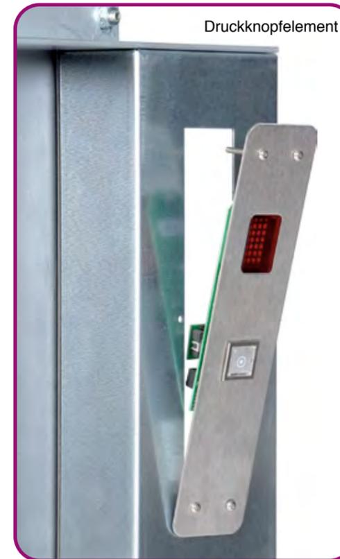
Das Druckknopfelement (DK) in den Zargenausschnitt einsetzen. Mit den vier Schrauben gleichmäßig die Klemmplatten anziehen. Die DK müssen in den entsprechenden Etagen eingebaut werden. Sie sind von unten nach oben, beginnend mit der Nummer 1, gekennzeichnet. Diese Benennung ist nicht identisch mit der Etagenbezeichnung auf der Anlagenzeichnung.
