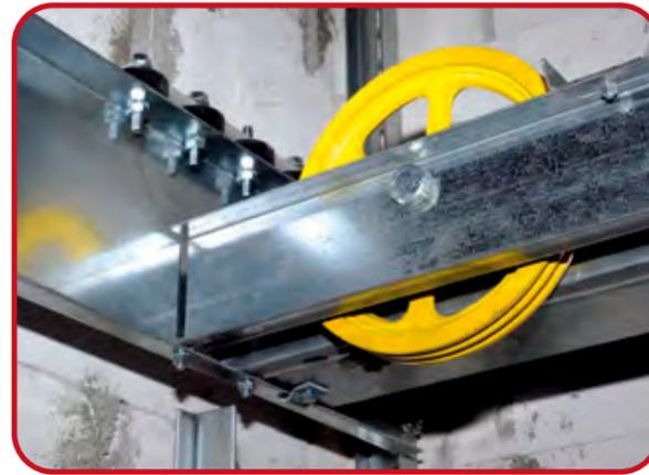
Die Seile werden vom Gegengewicht über die Treibrscheibe und den Umlenkrollenträger auf den Fahrkorb geführt.
