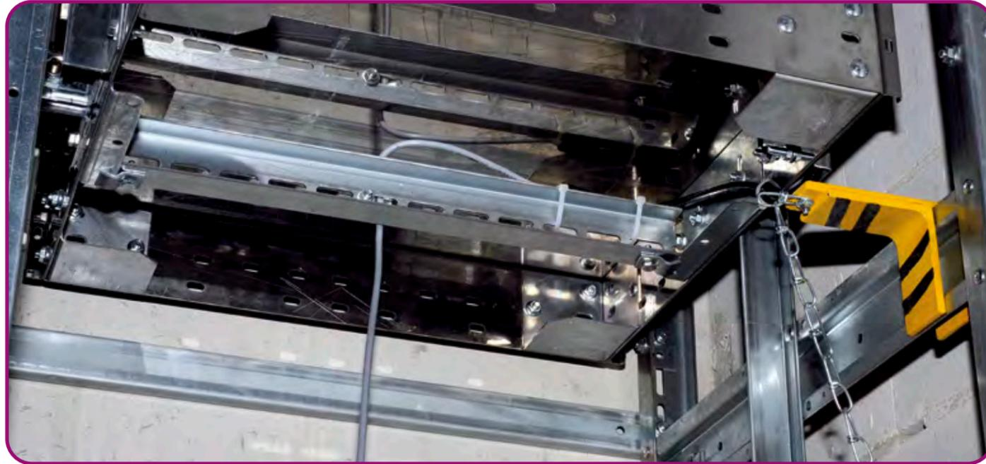
Die Elektrokomponenten am Fahrkorb sind vorinstalliert. Es muss lediglich das Hängekabel montiert werden. Dazu das Hängekabel durch die seitliche Führung auf der Gegengewichtsseite des Fahrkorbs verlegen und an der Hängekabelbefestigung unter dem Fahrkorb klemmen. Das Hängekabel im oberen Drittel des Gerüsts in den Kabelkanal laufen lassen. Die Länge so bemessen, dass es nicht auf dem Schachtboden schleift, wenn sich der Fahrkorb in der unteren Etage befindet.
