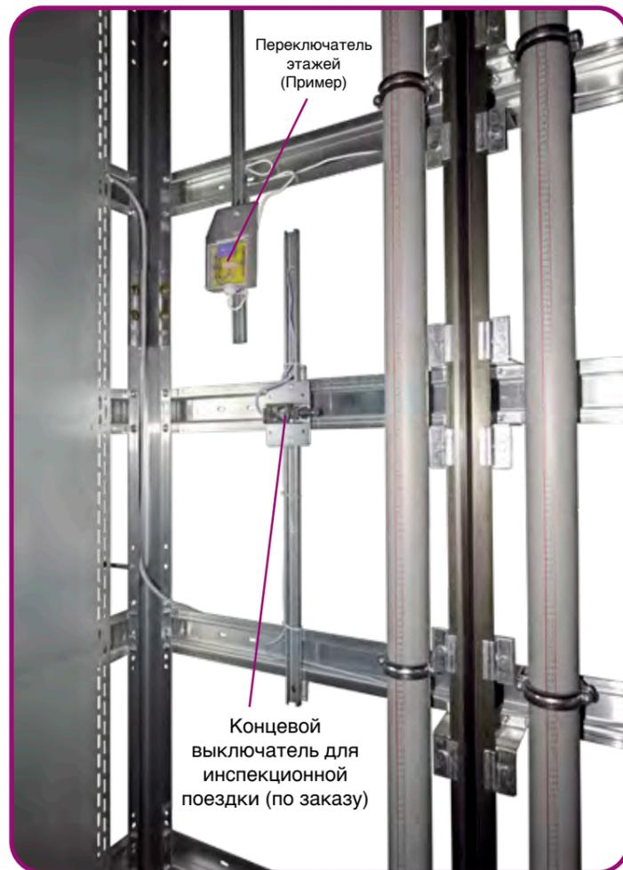
Переключатель этажей (магнитный переключатель) и концевой выключатель для инспекционной поездки (по заказу) крепятся на вертикально перемещаемой рельсе. Рельсы крепятся к U-образным профилям каркаса с помощью зажимов. Переключатель этажей и концевой выключатель для инспекционной поездки следует настроить согласно предписаниям (EN или TRA). Выключатели приводятся в действие кулачками в кабине и должны быть смонтированы.
