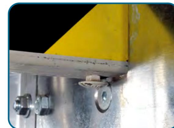
Рекомендуем подвешивать противовес ограничителя к профилям так, чтобы он оставался подвижным. Тогда противовес можно будет перемещать на профилях в процессе монтажа. Свободного места достаточно, чтобы разместить направляющую шину возле распорок при установке кабины.
