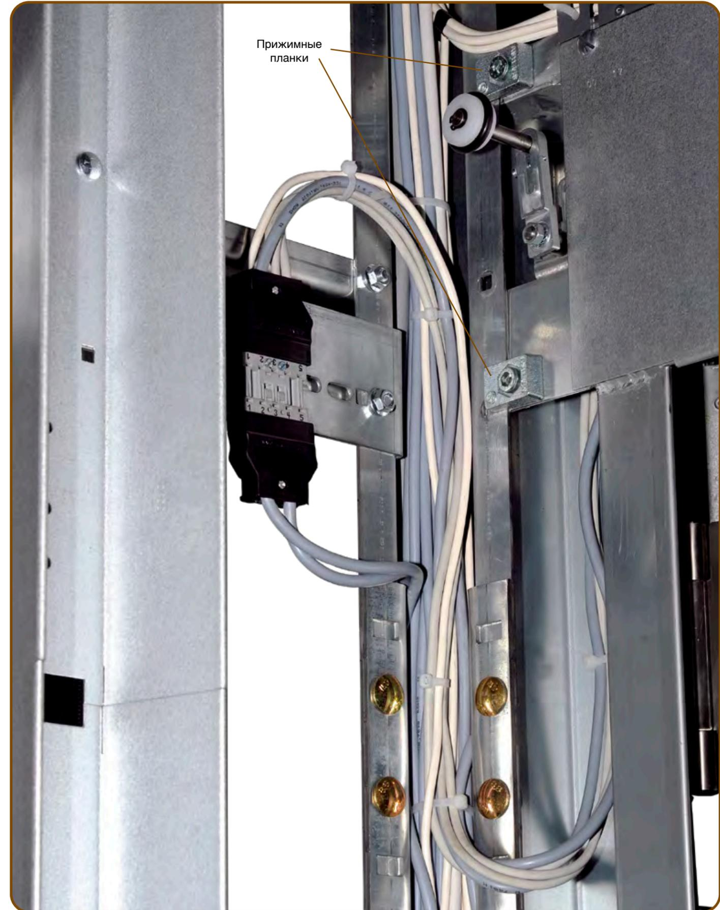
Дверной выключатель с замком поставляется в собранном виде и находится в верхней части дверной коробки. Коробка обшита, и переключатель не виден изнутри. Кабели проложены сбоку. При открытой двери замок и дверной контакт находятся в поле зрения. Муфта дверного контакта находится в дверной коробке. Штекер на полотне двери может регулироваться.
