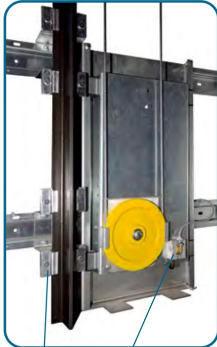
Tendeur de poids pour limiteur avec contact
