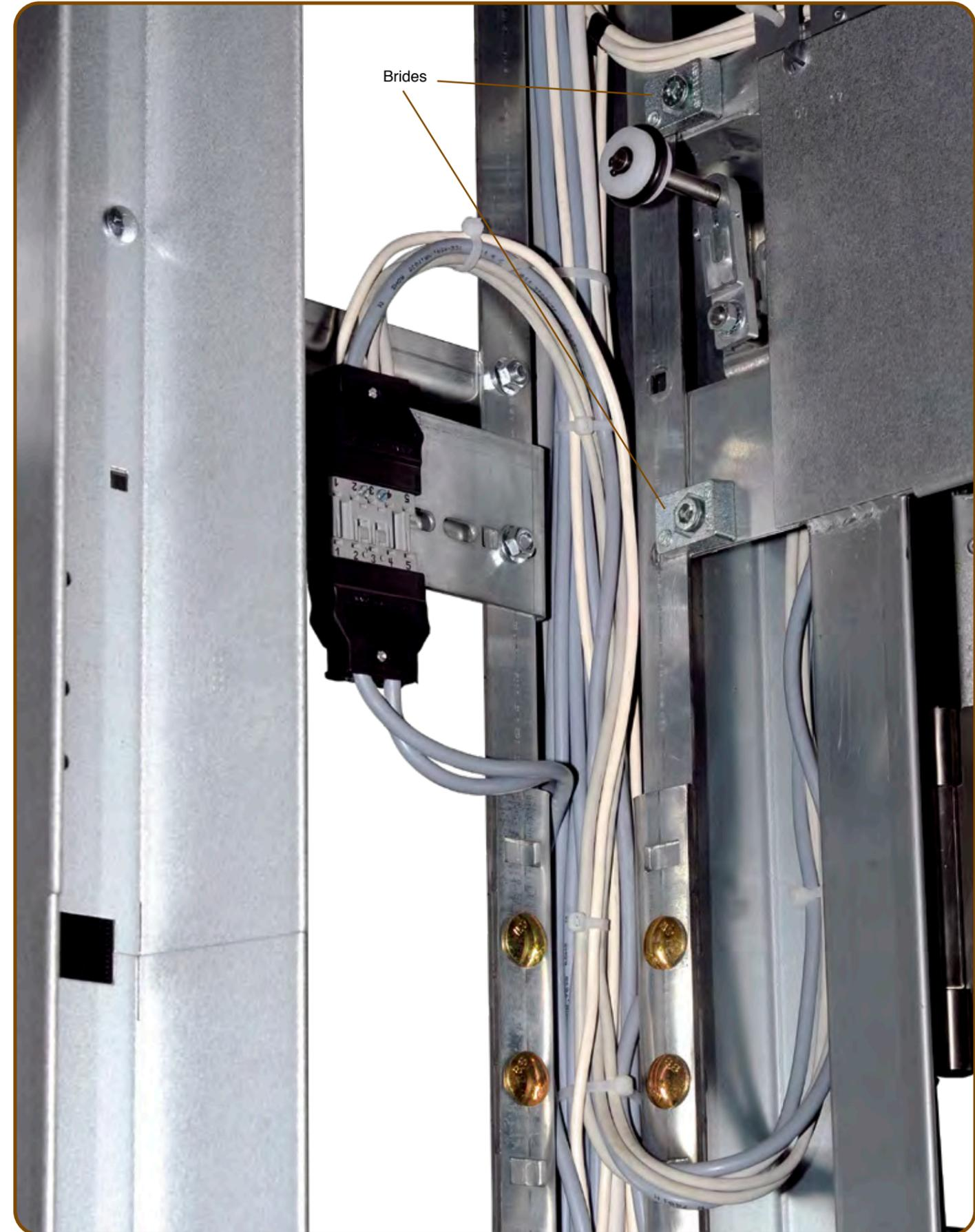
L'interrupteur de porte et le verrouillage sont prémontés et se trouvent dans le dormant du haut. Recouvrez le dormant de telle sorte que l'interrupteur de porte ne soit pas visible de l'intérieur. Tirez les câbles latéralement. Quand la porte est ouverte, vous voyez le verrouillage et le contact de porte. L'embrayage du contact de porte se situe dans le dormant. Le connecteur au vantail est réglable.
