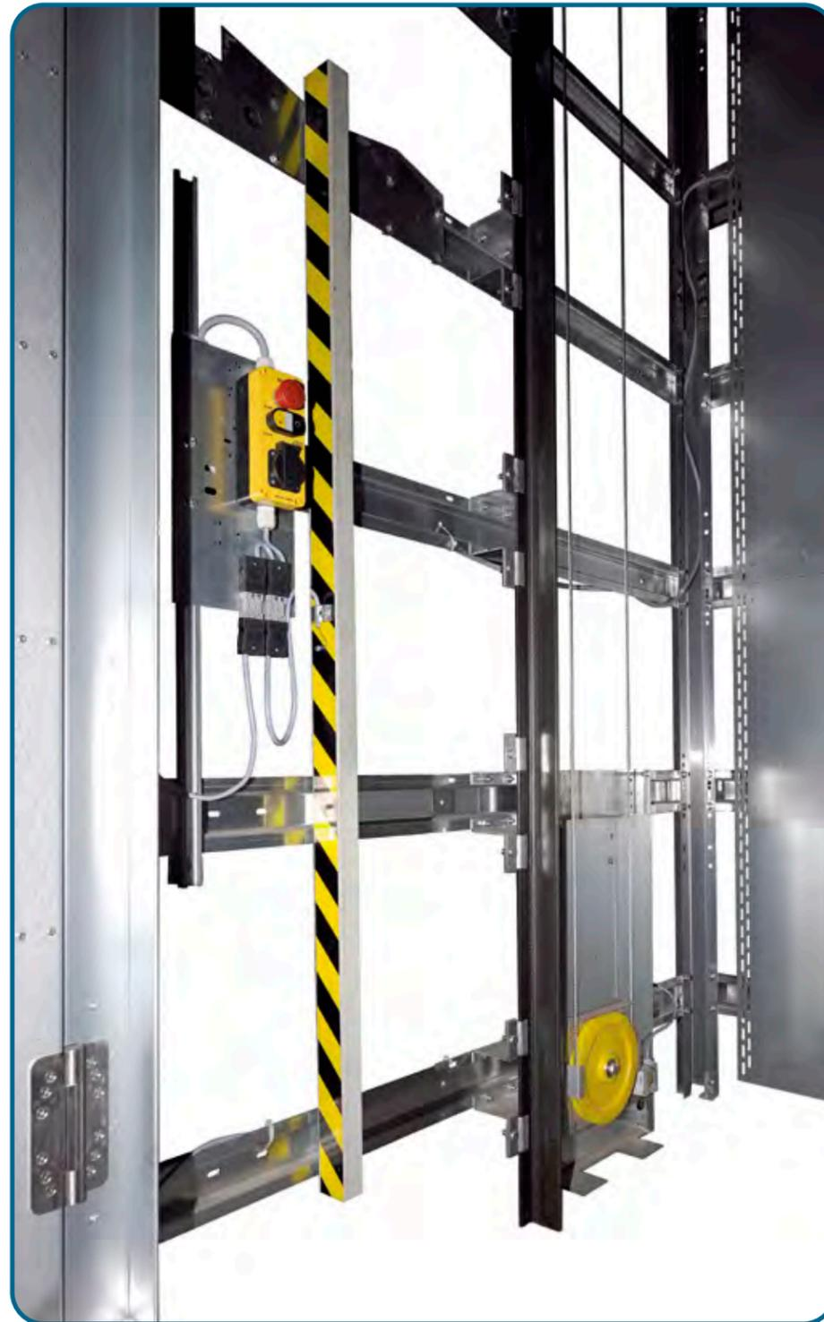
Vous pouvez à présent installer la benne dans le pylône préparé. Déplacez la benne dans le pylône jusqu'aux rails de guidage.
